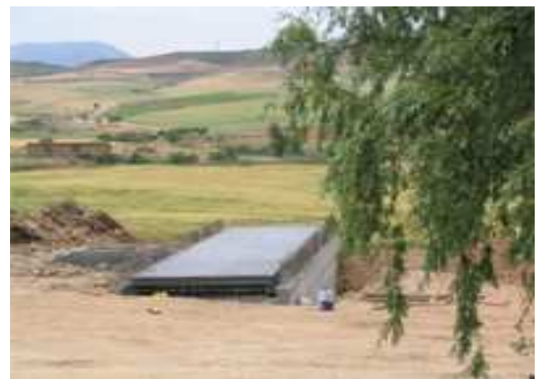
Estado actual de las obras de construcción de la báscula municipal
